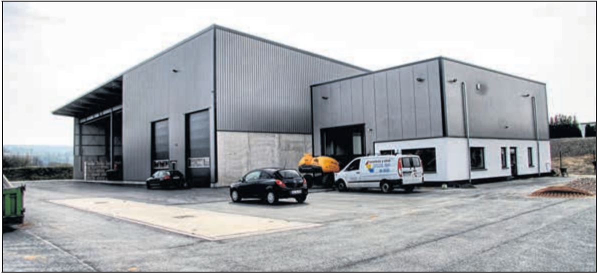
Das neue Entsorgungszentrum in der Straße Unter der Schirmeke 8 ist hochmodern.
