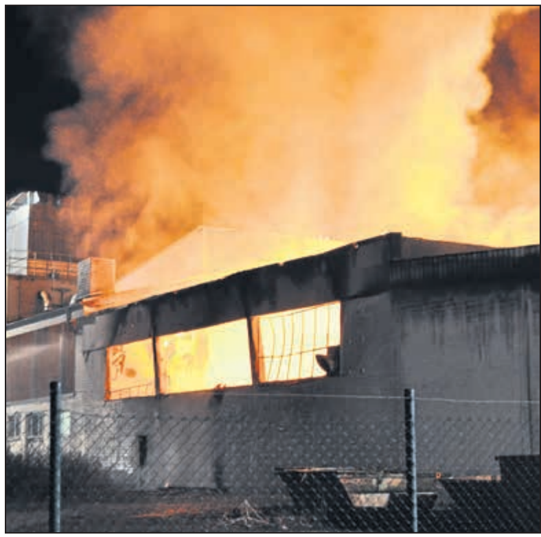
Die Flammen drohten, auf einen benachbarten Betrieb überzuspringen – die Feuerwehr konnte dies verhindern.
